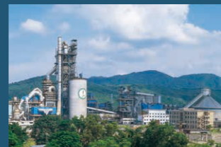
青洲水泥(雲浮)廠景
