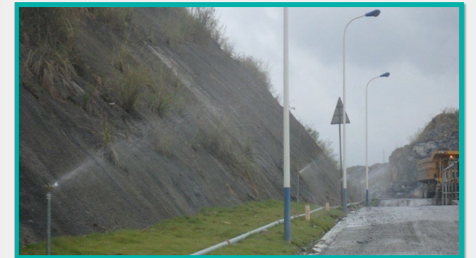
矿山道路喷淋系统
